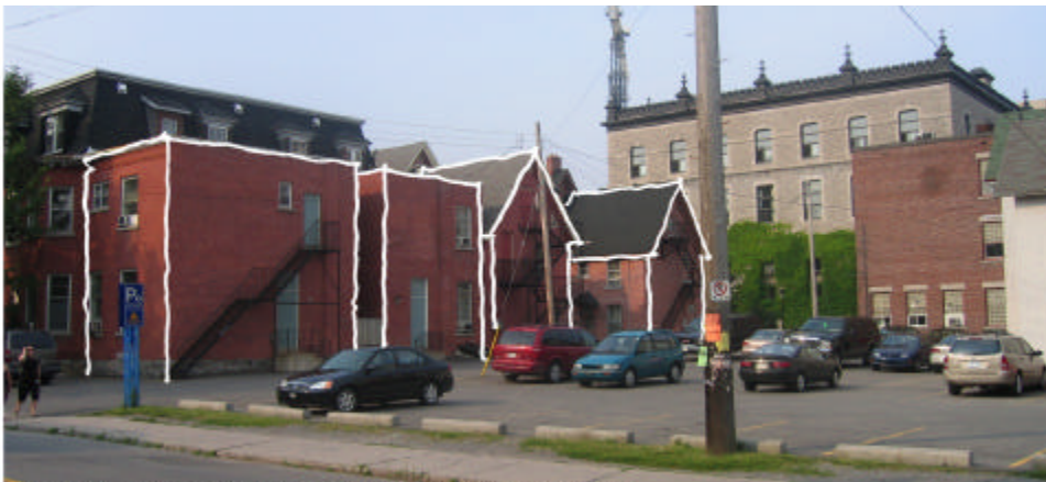
VIEW FROM CUMBERLAND STREET SHOWING REAR ADDITIONS TO BE DEMOLISHED VUE DE LA RUE CUMBERLAND MONTRANT LES AGRANDISSEMENTS ARRIÈRE QU'ON DOIT DÉMOLIR
