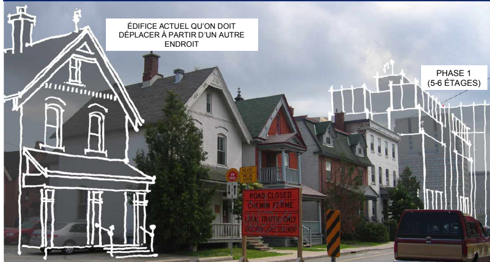
CÔTÉ SUD DE LA RUE STEWART MONTRANT LES ÉDIFICES QU'ON DOIT DÉPLACER TEMPORAIREMENT AFIN DE POUVOIR CONSTRUIRE LE STATIONNEMENT SOUTERRAIN
