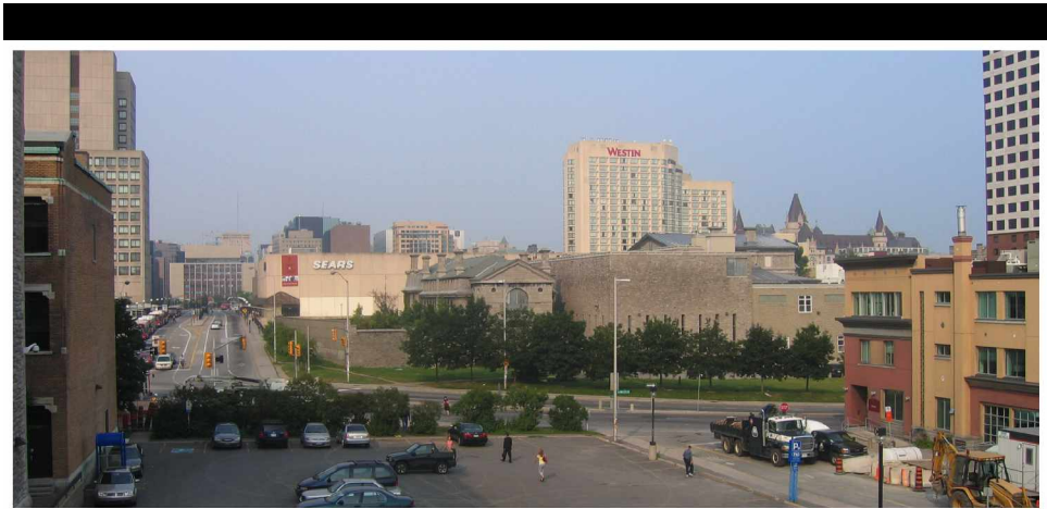
STEWART / WALLER PARKING LOT LOOKING WEST TOWARDS PROPOSED LRT ALIGNMENT ON MACKENZIE KING BRIDGE VUE DU TERRAIN DE STATIONNEMENT STEWART/WALLER VERS L'ALIGNEMENT PROPOSÉ DU TLR SUR LE PONT MACKENZIE-KING
