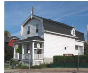
Existing wood-frame house on Beechwood Avenue. Maison à ossature de bois de l'avenue Beechwood
