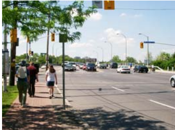
Traffic on St. Patrick's Bridge Circulation sur le pont St-Patrick
